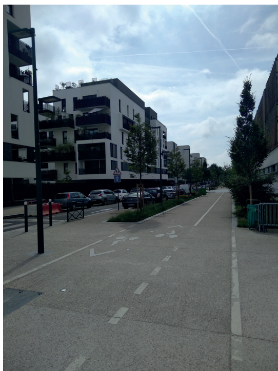
Photo 1 Avenue Chenard et Walker à Chandon-République avec une piste cyclable aménagée sur le trottoir
